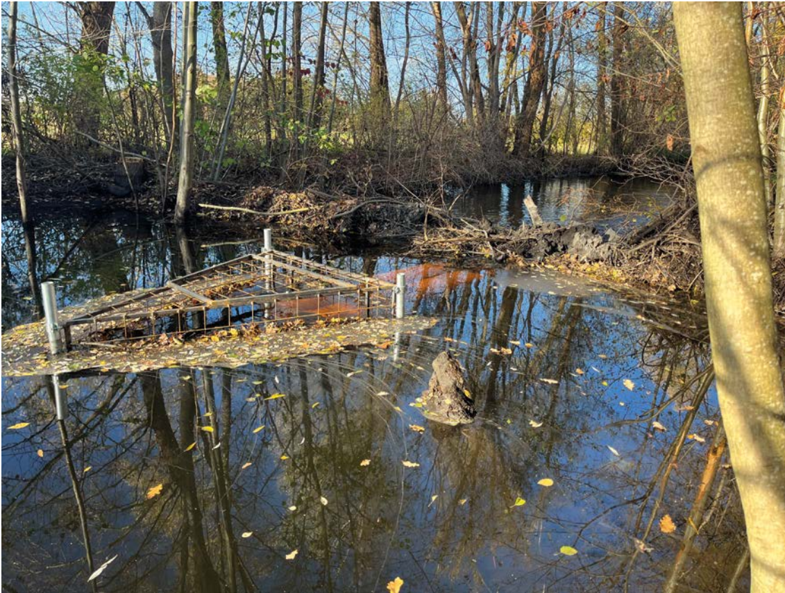
Abbildung 23: Dammdrainage mit Drahtkorb.
