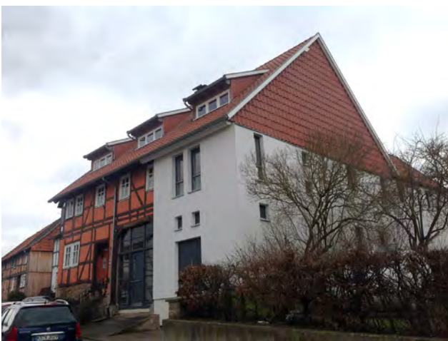
Beispiel für einen Anbau in Breuna
