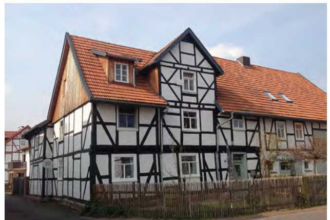
Dach mit Zwerchhaus, Unterrieden
