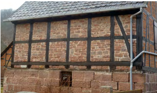
Großalmeröder Dachziegel, Ausfachung aus Bruchstein, Sandsteinsockel, Werleshausen
