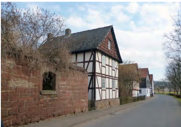
Traufständiges Gebäude mit Hof, Werleshausen
