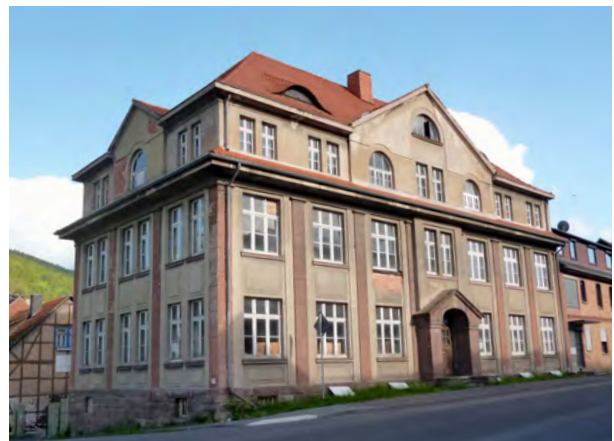
Fabrikgebäude aus dem frühen 20. Jh., Hundelshausen
