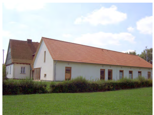
Beispiel für einen Neubau in Armsfeld, Bad Wildungen
