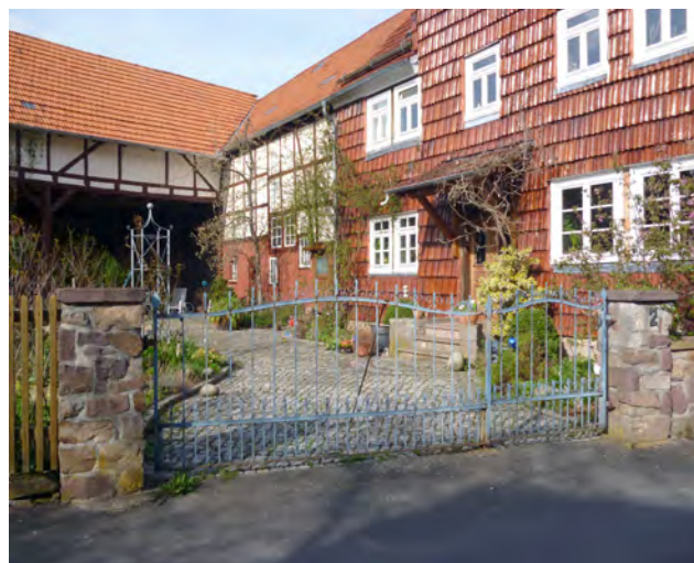
Hofzufahrt mit Sandsteinsäulen und Metalltoren, Ermschwerd
