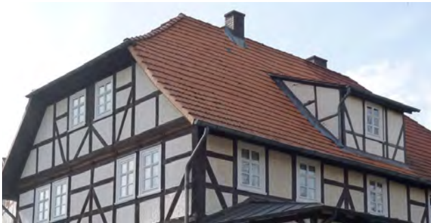
Krüppelwalmdach mit Gaube, Ermschwerd
