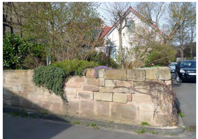
Trockenmauer aus Bruchstein, Ermschwerd
