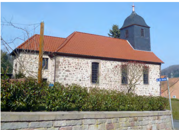
Sandstein und Muschelkalk als Materialien für Bauwerk und Einfriedung, Ziegenhagen
