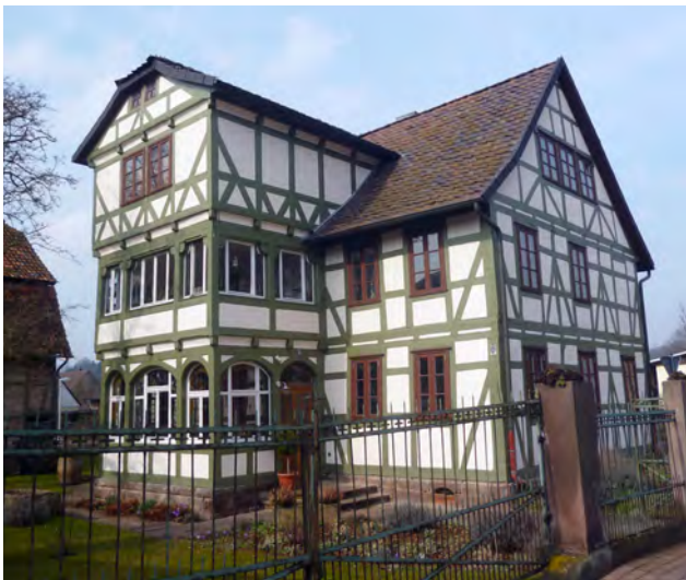
Gliederung der Fassade durch Fachwerk, Unterrieden
