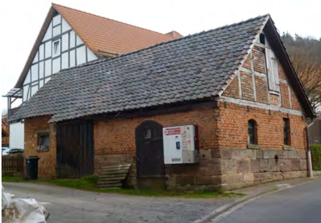
Ausgemauerte Gefache an einem ehemaligen Backhaus, Roßbach
