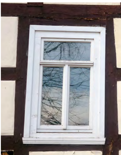
Zweiflügeliges Fenster mit Oberlicht, Werleshausen
