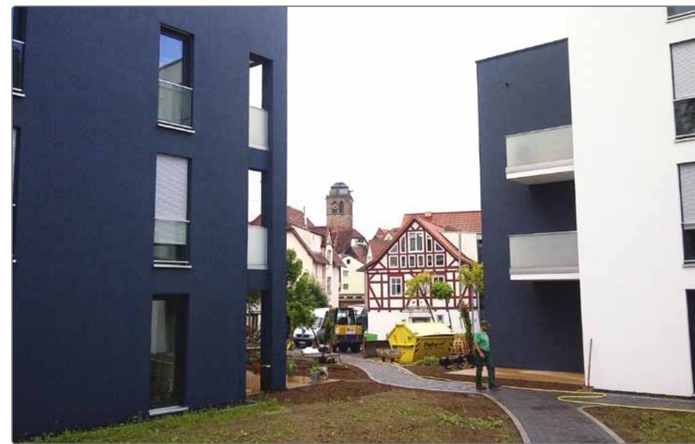
Rückbau / Neubau Beispiel: Bad Hersfeld
