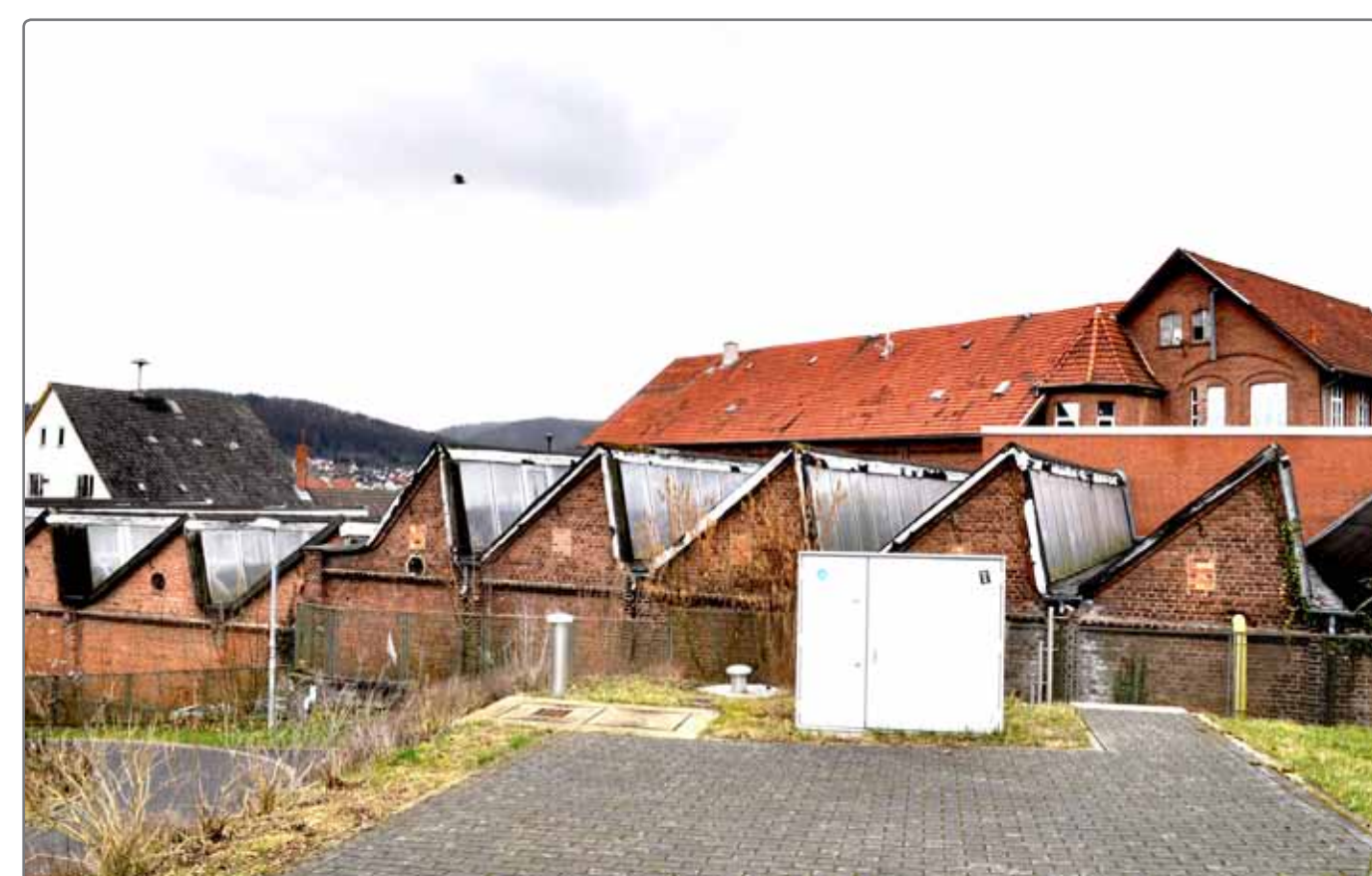
Sanierung und Entwicklung
